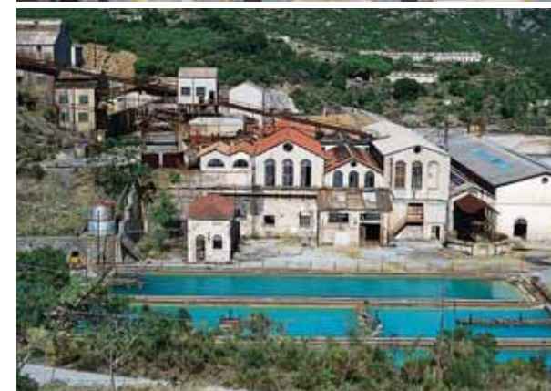
Nelle foto di questa pagina: il Medio Campidano, soprattutto nei territori dell'Arburese e dell'Iglesiente, ha vissuto una secolare epopea mineraria, di cui oggi si vedono testimonianze di archeologia industriale (qui sopra) o di vita "agiata", come dimostra l'elegante palazzo della direzione, restaurato a Montevecchio (in alto).
